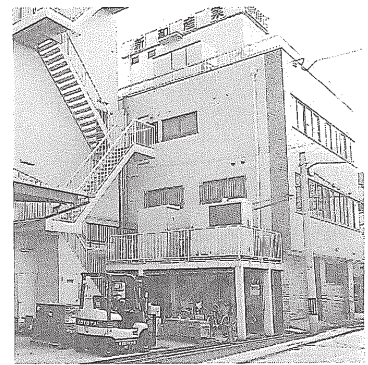
本社にはコージェネを設置
