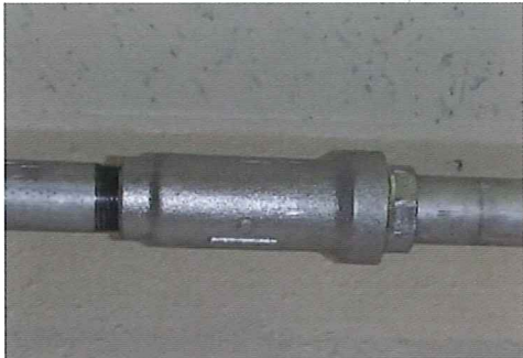
各種メカニカル継手設置状況
