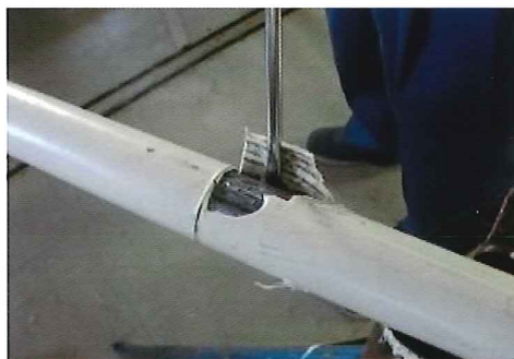
ドライバーとハンマーを用いた剥離作業とその剥離状況
