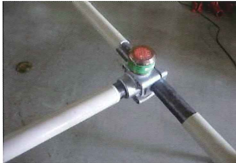
各種メカニカル継手設置状況
